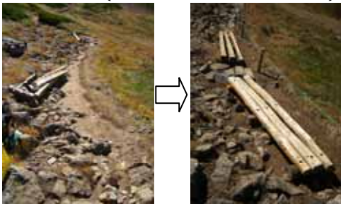
【歩道設置（水晶小屋より鷲羽岳方面）】
