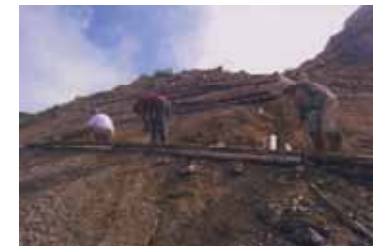
(人力で木製階段を設置)
