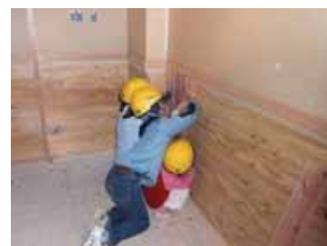
(交流施設のスギの腰壁設置)
