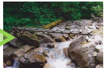
木橋の補修整備
