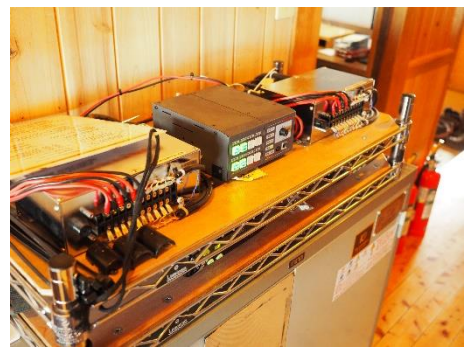
無線装置稼働用電源の更新
